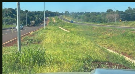
Canteiro de rodovia: antes e depois
